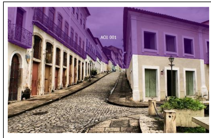
Abbildung 9: Beispiel AOI oberer Fassadenbereich
